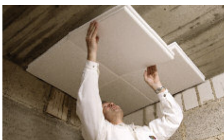
Energie sparen: Die Dämmung von Keller- und Geschoßdecke vermindert Wärmeverluste.
