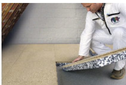
Energie sparen: Die Dämmung von Keller- und Geschoßdecke vermindert Wärmeverluste.
